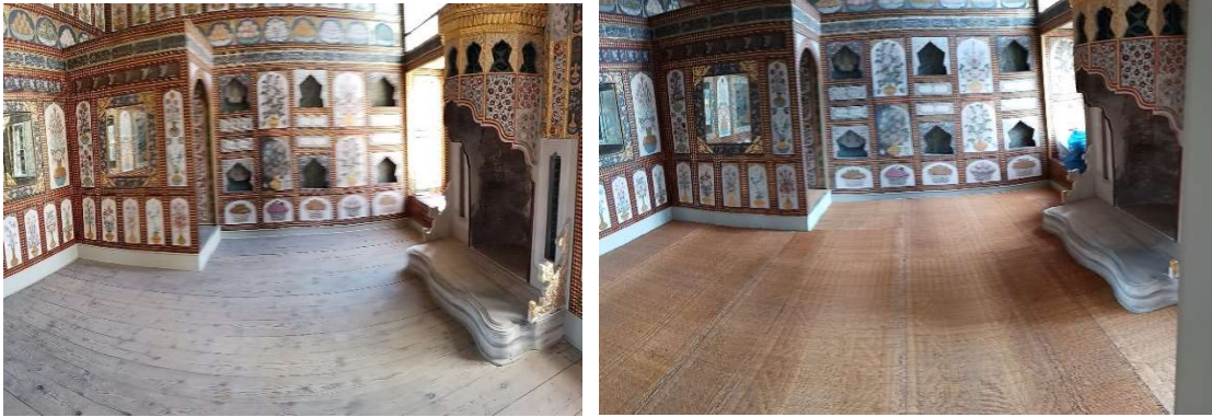
(Restorasyon Öncesi ve Sonrası)
